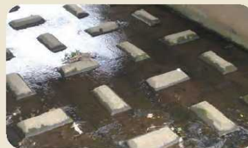
床止工（護床工）
